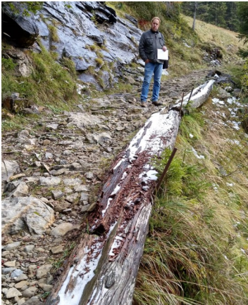
Objekt 41: Mauerabbruch unterhalb Passübergang
