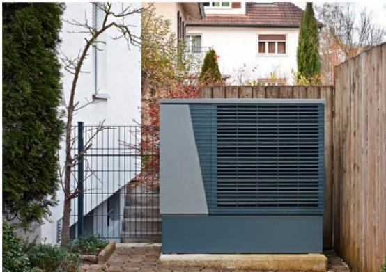
Bild: Aussen aufgestellte Luft/Wasser-Wärmepumpe
